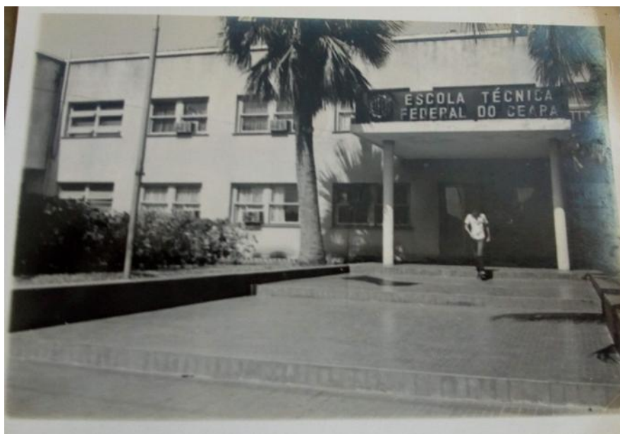
Figura 1- Fachada da Escola Técnica Federal do Ceará.
