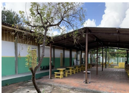
Imagem 50 – Acesso às salas de aula
